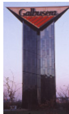
Logo przedsiębiorstwa cukierniczego Agrate Brianza w Mediolanie jest podtrzymywane przez wieżę o wysokości 22 m obłożoną płytami ze stali nierdzewnej o kolorze nakładanym elektrolitycznie.
