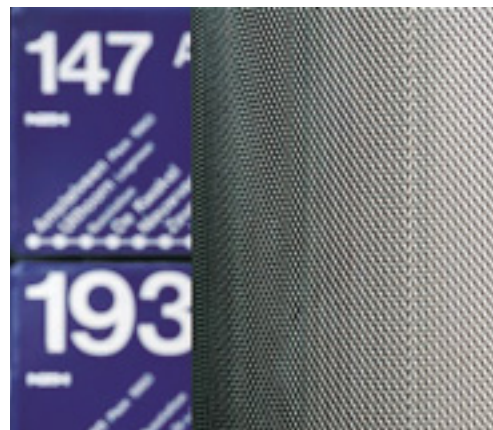
Słupy na dworcu autobusowym w Amstel w Holandii zostały obłożone stalą nierdzewną walcowaną z wzorem - jest to idealna powierzchnia dla obszarów aktywnego ruchu pieszych.
